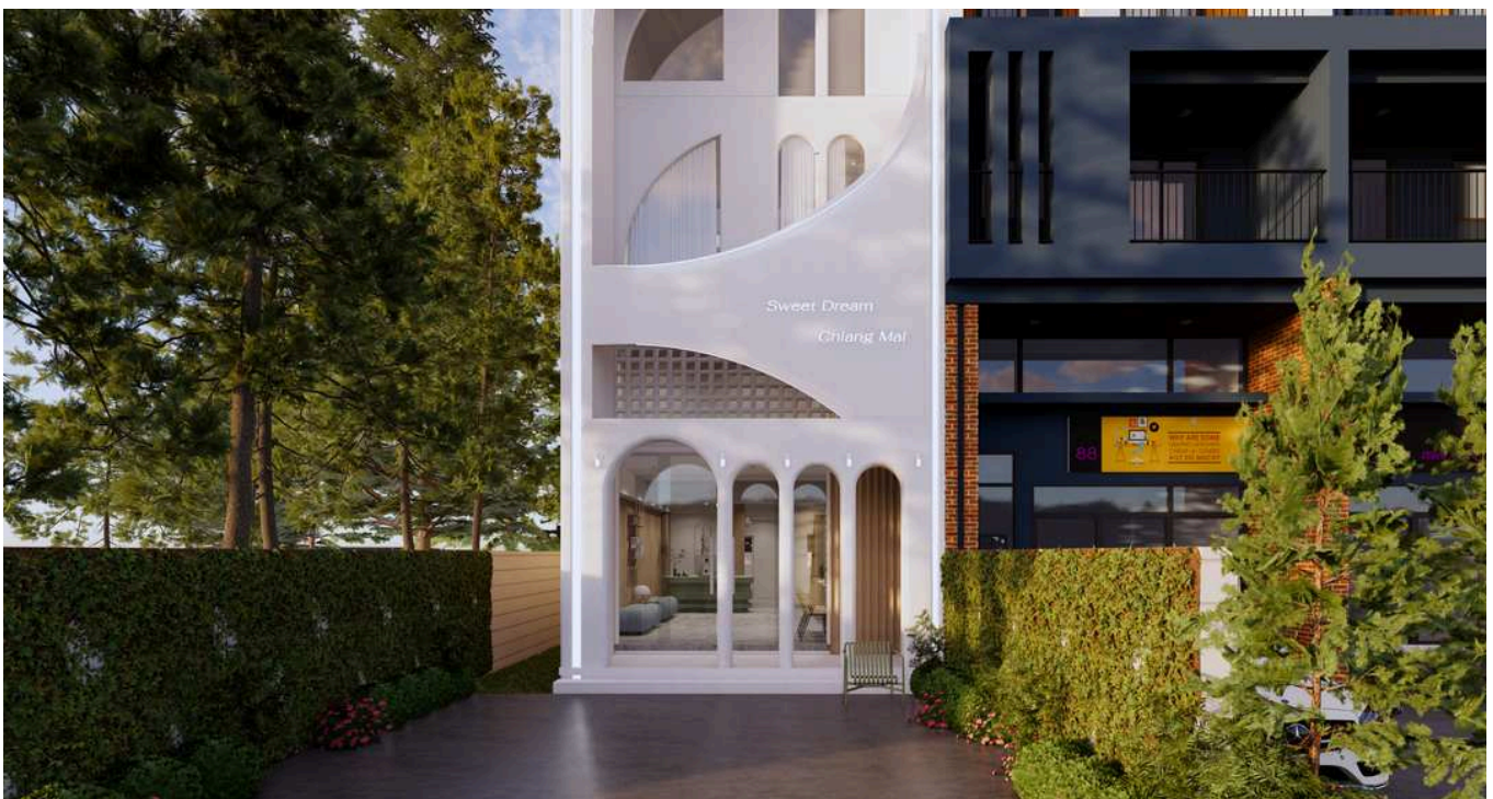
รูปแบบการจัดวางอาคารใช้โครงสร้างเดิมที่มาปรับปรุง ในแนวคิดฝันหวานที่มีความสบายตาและสนุกสนานเข้ามาทำให้อาคารยังคงรูปแบบเดิมแต่ดูเหมือนใหม่
